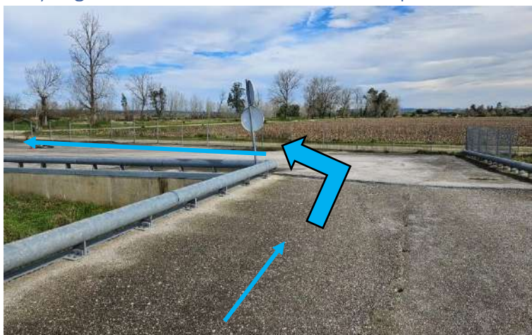
Figura 21 - Início do ponto referente a curva que antecede curva em cotovelo, entre os 2º e 3ºkm na volta 1 e entre os 7º e 8ºkm na volta 2 (vista do interior do centro náutico, no sentido da corrida).
