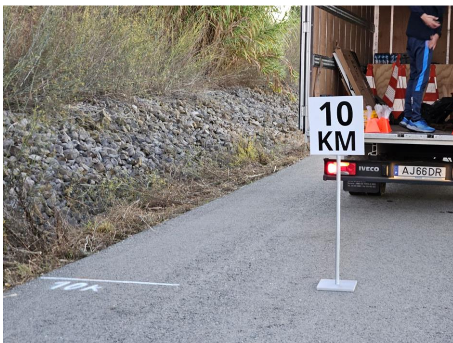
Figura 18 – construção dos pontos quilométricos de referência de 5km, 10km, 15km e 20km (na foto, exemplo do ponto referente ao km 10)
